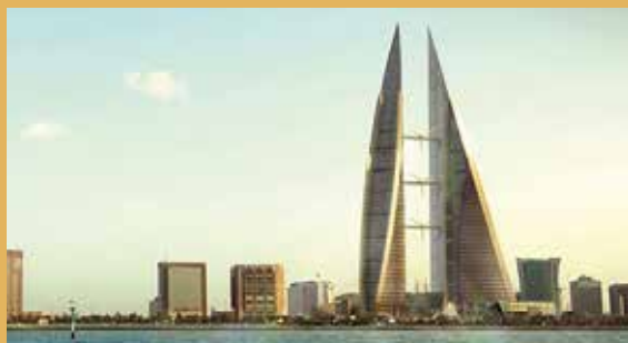
The Bahrain World Trade Center - mellem tårnene er der Vestas vindmøller
