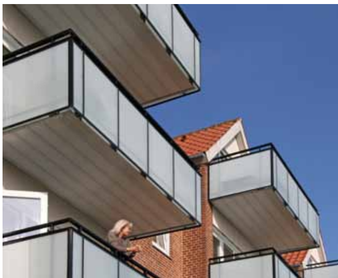
Afd. 10 – en beboer nyder udsigten fra sin nye altan
