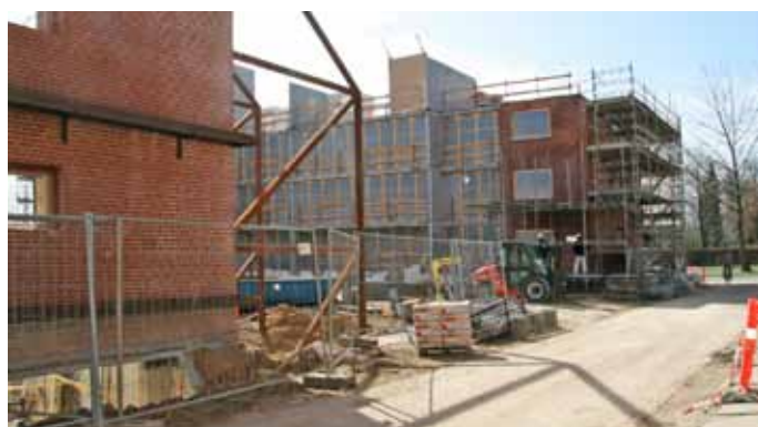
Afd. 1 – Elevator tårne og facader er ved at tage form
