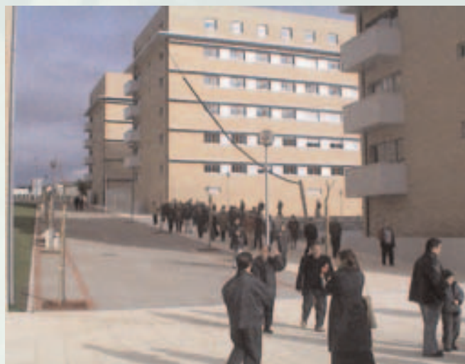
NORBICETA, konsortium af kooperativer, Porto. Matosinhos-projektet, 101 øko-boliger (i byggeriets 2. fase. Fotoet viser den ikke bæredygtige del af byggeriet).
