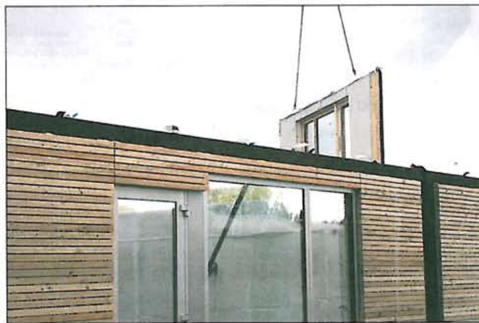
Elementerne løftes på plads, så bygningen lukkes af på en dag. Med efterfølgende trykprøvning af hver enkelt bolig sikres, at byggeriet er helt tæt.
