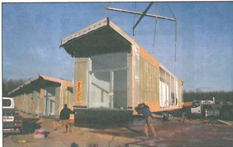
Petersminde i Åbyhøj er 26 rækkehusboliger til seniorer og 63 2-rums ungdomsboliger. De er bygget med rumstore moduler på 4 x 12 meter. Et enkelt modul til en ungdomsbolig og to til en ældrebolig. Ungdomsboligerne er i op til 2 og 3 etager, hvor det tog under en uge at opstille en blok på 47 boliger.
