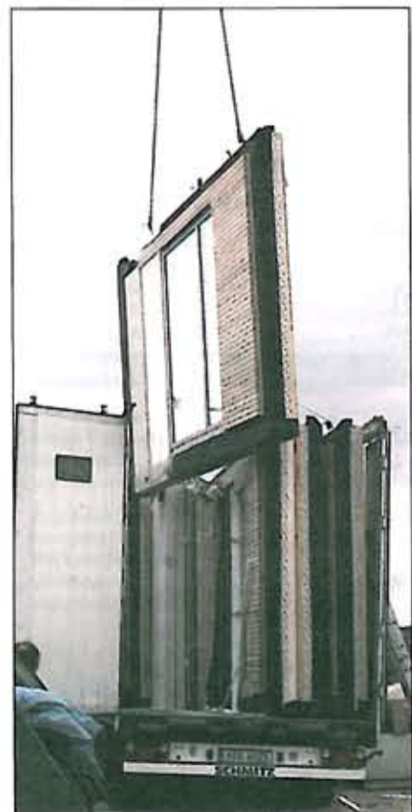
Elementerne løftes på plads, så bygningen lukkes af på en dag. Med efterfølgende trykprøvning af hver enkelt bolig sikres, at byggeriet er helt tæt.
