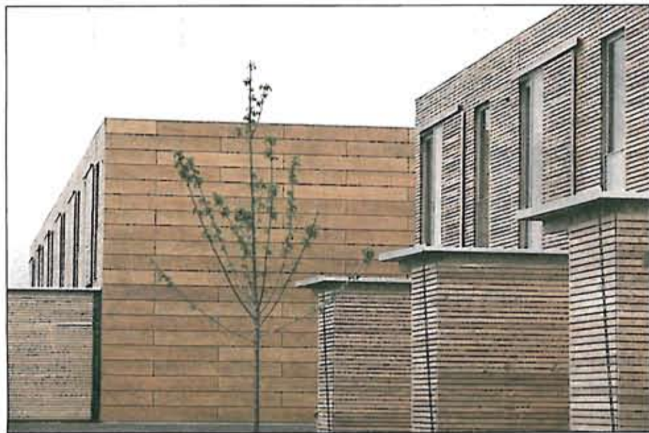
Lærkehavens første etape på 50 boliger er opført af præfabrikerede sandwichelementer af træ. Facade, indvendige vægge, døre og vinduer er monteret klar til brug.
